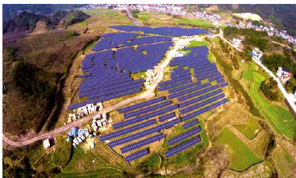
地面光伏电站
